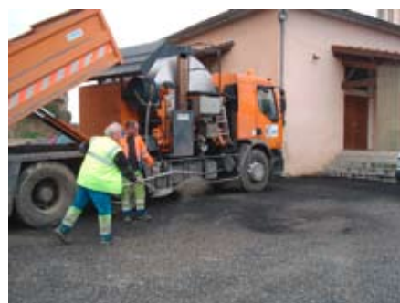
Travaux de voirie
